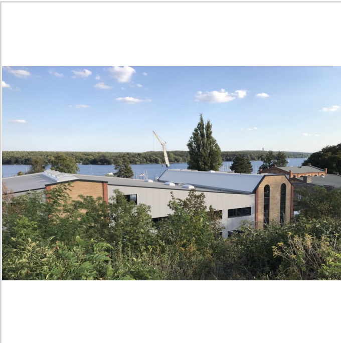
Haus von Außen
